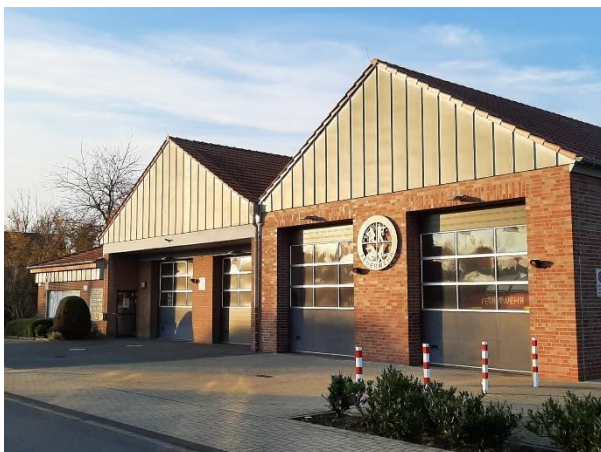
Erweiterung des Feuerwehrgebäudes in Walstedde
