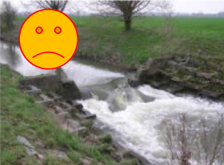
Pfeifenbring'sche Kaskade St. 42+620
