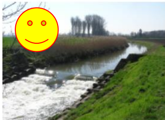
Pfeifenbring'sche Kaskade St. 33+830
