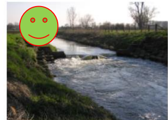
Pfeifenbring'sche Kaskade St. 35+460
