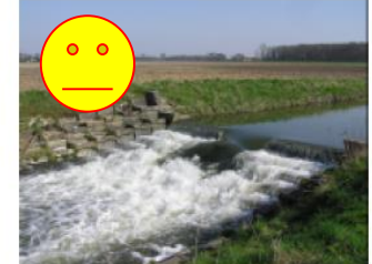
Pfeifenbring'sche Kaskade St. 29+520
