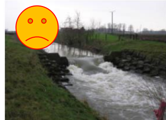
Pfeifenbring'sche Kaskade St. 43+820
