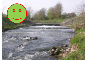
Abstürze St. 27+470 Alberloh Nord
