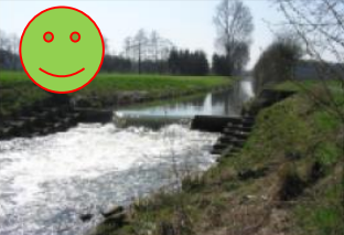
Pfeifenbring'sche Kaskade St. 31+640
