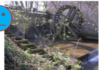
Historisches Mühlenwehr St. 37+780 (histor. Wehranlage Hs. Landsberg) Drensteinfurt
