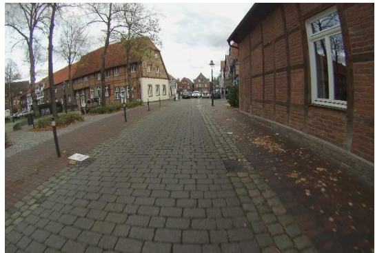
Abb. 3.6-8 Schmale Fahrbahnbreite insbesondere bei entgegenkommendem Kfz-Verkehr auf der Mühlenstraße (eigene Aufnahme)
