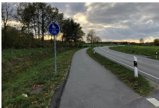
Abb. 3.5-4 Gemeinsamer Geh- und Radweg, L 850 bis Hemmer (Zweirichtungsverkehr) (eigene Aufnahme)
