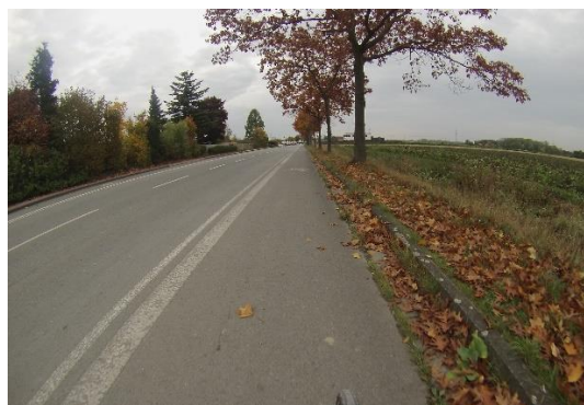
Abb. 3.5-5 Radfahrstreifen auf der K 21 (eigene Aufnahme)
