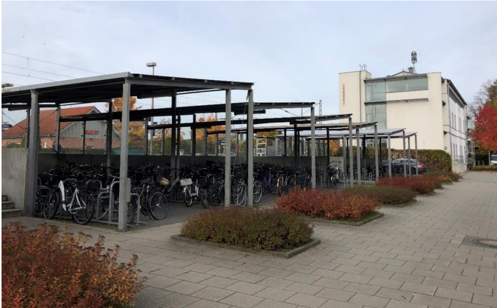
Abb. 2.5-1 Überdachte Radabstellanlage am Bahnhof Drensteinfurt (eigene Aufnahme)
