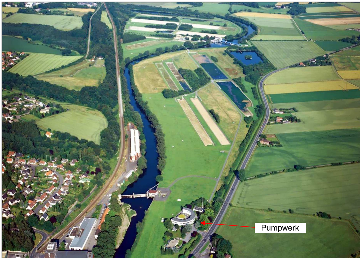
Abbildung 9: Wasserwerk Haltingen – Pumpwerk und Wassergewinnungsgelände
