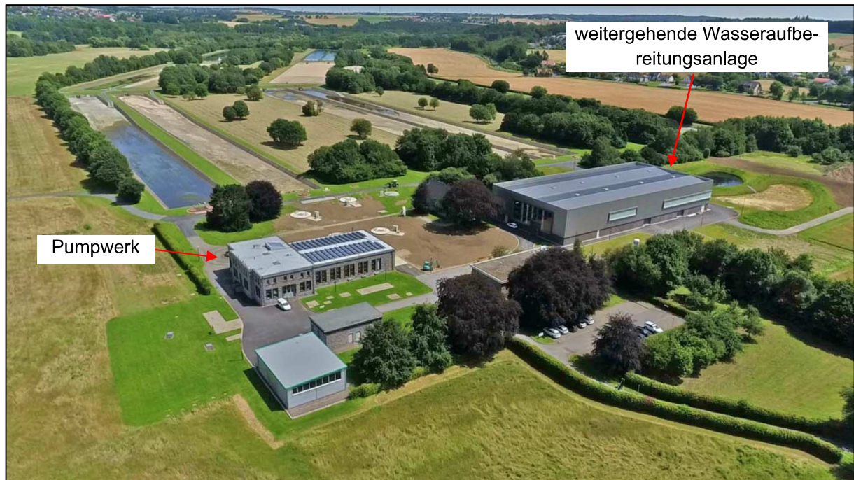
Abbildung 7: Wasserwerk Echthausen - Wassergewinnungsgelände, Pumpwerk und Wasseraufbereitungsanlagen
