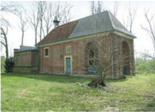
Ansicht von außen
