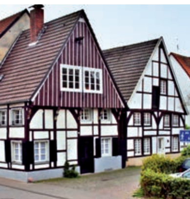
Das Doppelgadem von innen und außen
