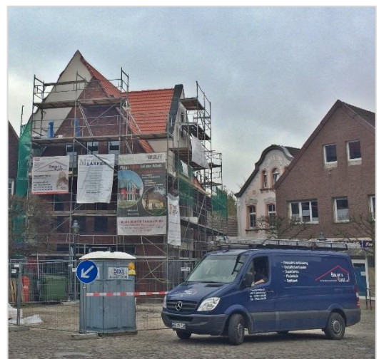
Baustelle Markt 2 im April 2018 Foto: Citymanagement Drensteinfurt
