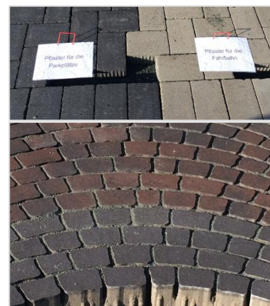
Drei verschiedene Sorten von Pflastersteinen werden zukünftig auf dem Marktplatz verlegt (s. o.). Aufenthalts- und Verkehrsflächen sind klar unterscheidbar.
