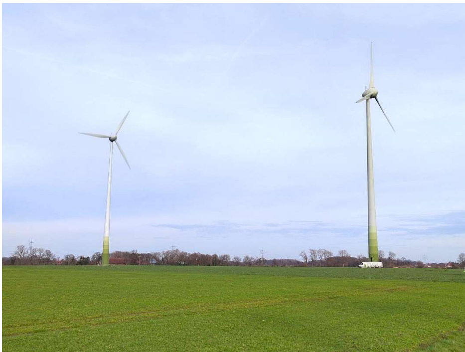
Abb. 24: Windenergieanlagen Drensteinfurt/Ameke (Eigene Aufnahme)
