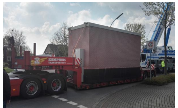
Aufstellung des 1. Glasfaserverteilers Point of Presence (POP) in Drensteinfurt
