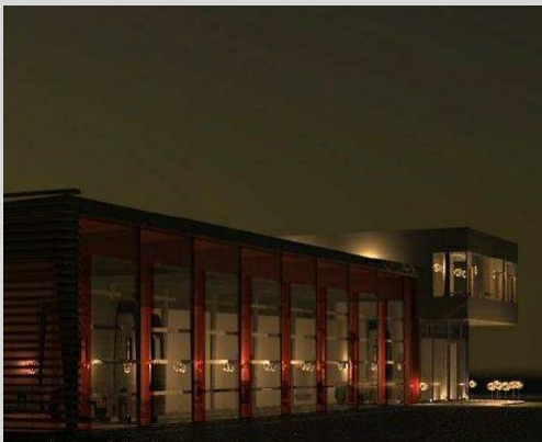
Neubau Feuerwehr Drensteinfurt
